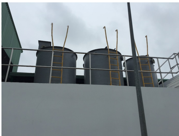
- Lắp đặt bồn Composite chứa hoá chất xử lý nước cho nhà máy Toyota Giken - KCN Nội Bài
