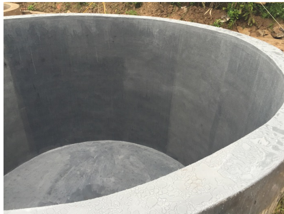
- Bọc Composite téc chứa chất thải độc hại cho công ty môi trường VK - Phù Lãng - Quế Võ - Bắc Ninh
