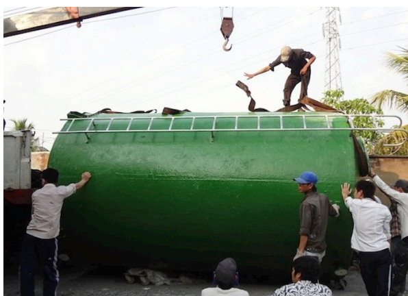
- Bọc Composite 1200 m2 bể chứa hoá chất nhà máy thép Thiên Trường - Mỹ Hào - Hưng Yên
