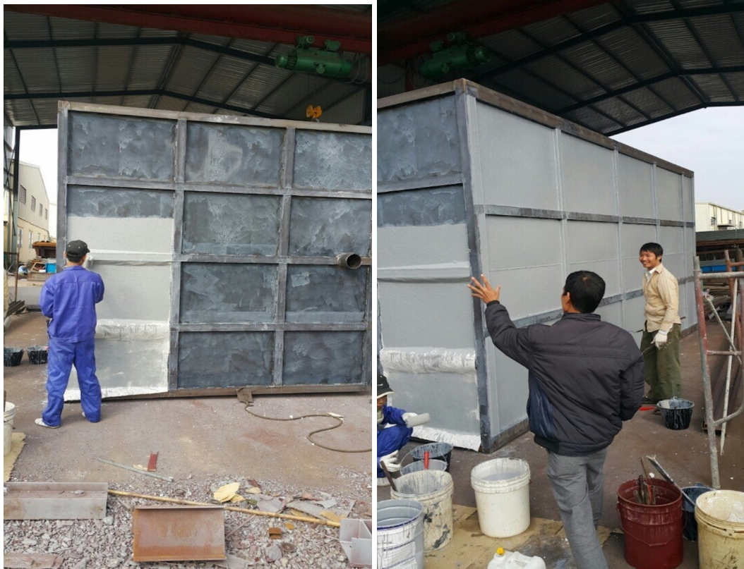
- Bọc Composite chống gỉ cho 500 m2 bồn chứa hoá chất sơn nhúng nhà máy DOKA - Phủ Lý - Hà Nam
