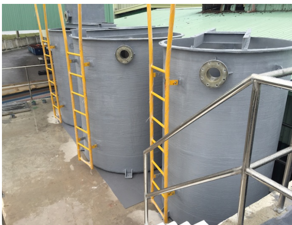
- Lắp đặt bồn Composite chứa hoá chất xử lý nước cho nhà máy Toyota Giken - KCN Nội Bài
