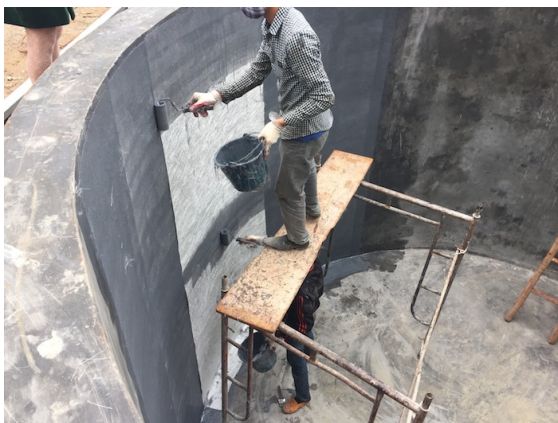
- Bọc Composite téc chứa chất thải độc hại cho công ty môi trường VK - Phù Lãng - Quế Võ - Bắc Ninh
