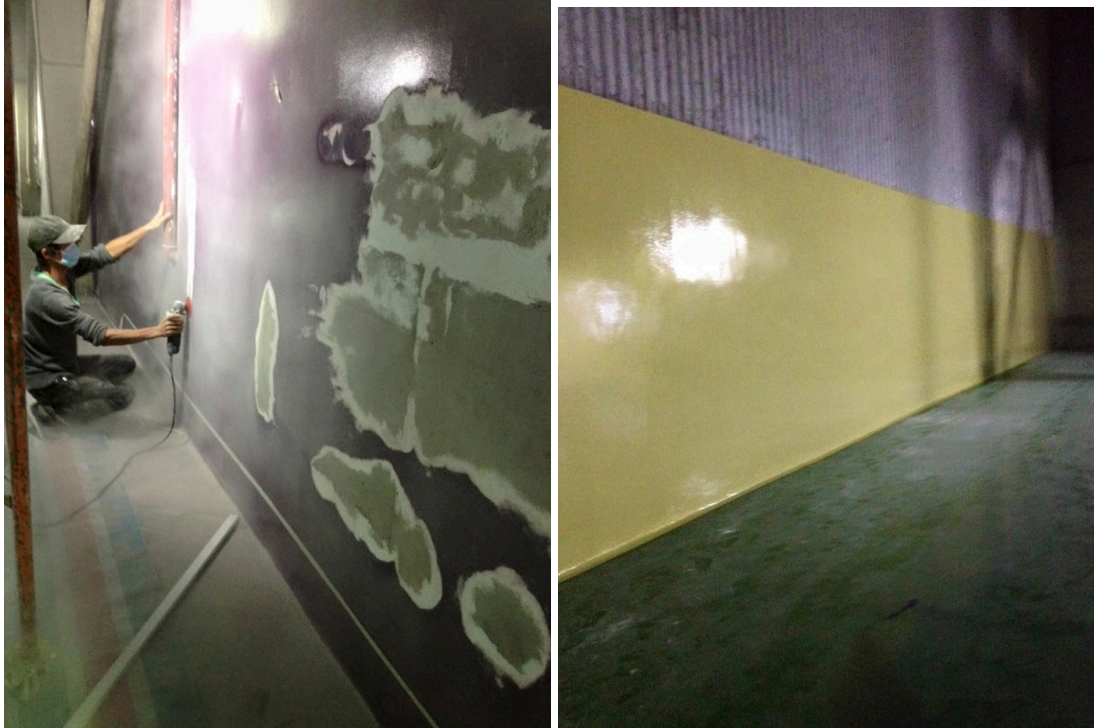
- Bọc Composite chống gỉ cho 500 m2 bồn chứa hoá chất sơn nhúng nhà máy DOKA - Phủ Lý - Hà Nam
